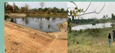
อ่างเก็บน้ำคลองทับจันทร์ พิกัด : 130 หมู่ 3 ต.คลองทับจันทร์ อ.อรัญประเทศ จ.สระแก้ว
